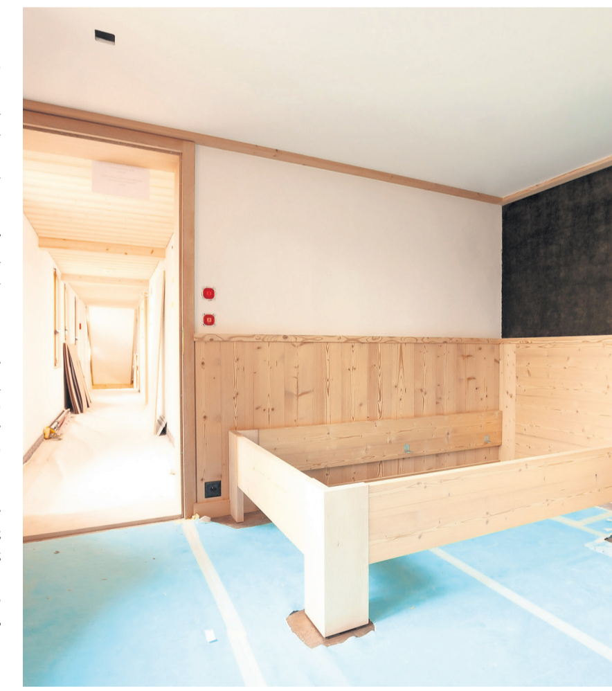
Einzelzimmer während des Umbaus.
